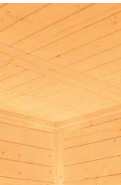
Decke aus Massivholz
